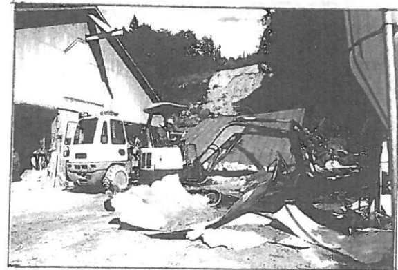
(牛舎の土砂撤去工事)
