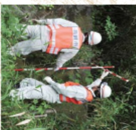
傾斜地では、のり面のブロックに亀裂やゆがみがないか確認
