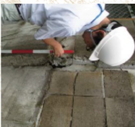
市職員が住宅地でのブロック塀の状態などを点検
