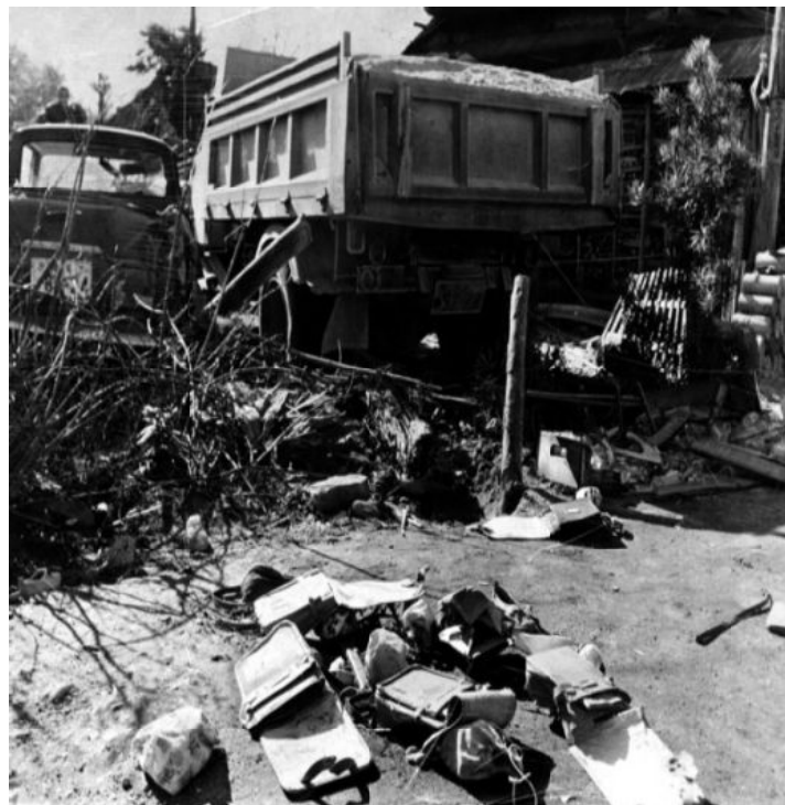
ランドセルが散乱する事故現場。奥が突っ込んだダンプ。
