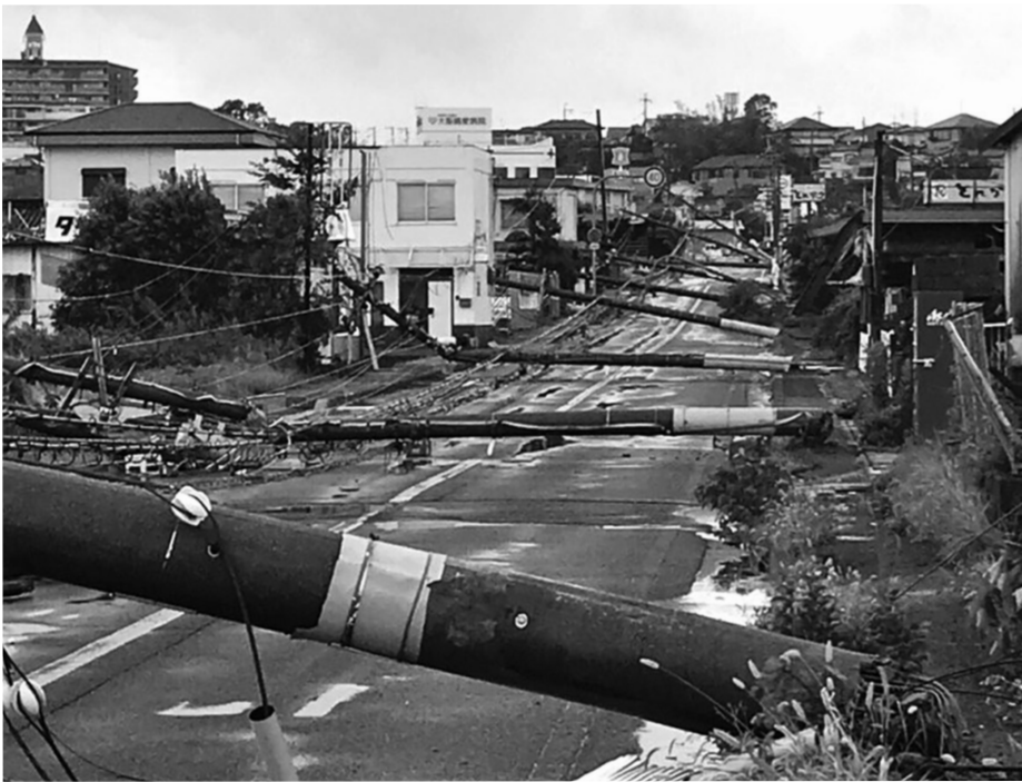
凄まじい暴風雨によって、住宅街の電柱が倒されました。（9月4日大阪府内）
