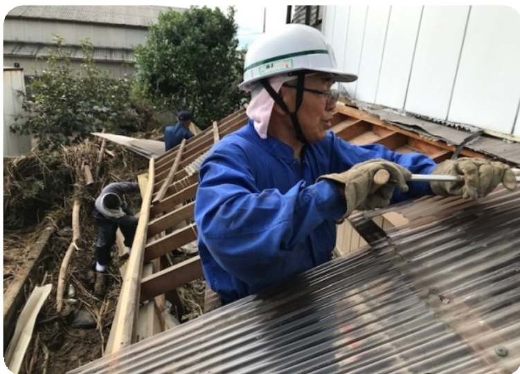
ボランティアセンターでは対応できない解体作業も。
