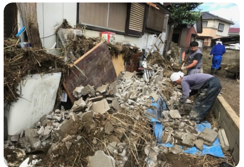
水圧で押し倒されたブロック塀の撤去作業
