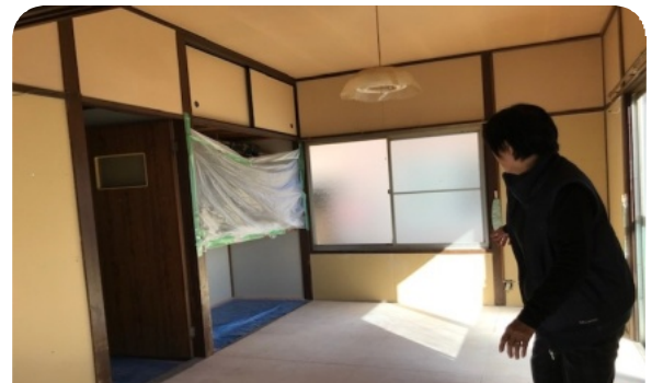
押入れに避難してあの窓から救出されました
