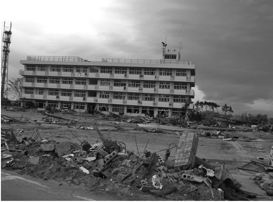
大津波が押し寄せて流され、荒れ果てた小学校の様子（仙台市内）
