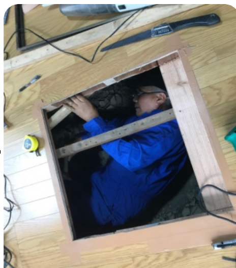
建設職人橋本さんによる床下作業
