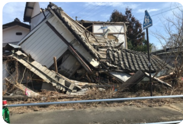
崩壊したままの住居(2/12双葉町)
