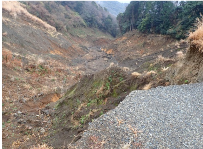
崩落現場上部からの状況。まだ盛土が残っている。
