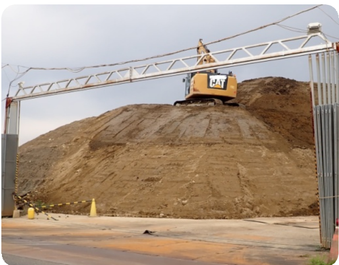
残土が積み上がる埼玉県三郷市にあるストック場。
