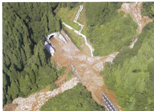
上空からの土砂流入現場
