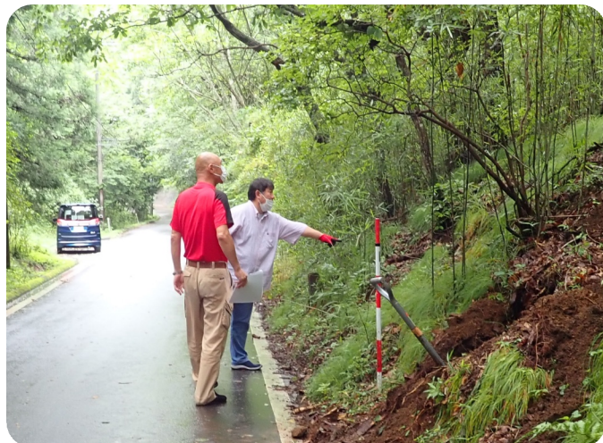
組合による現場検証の様子。周囲の樹木に比べ明らかに危険な状態でした。
