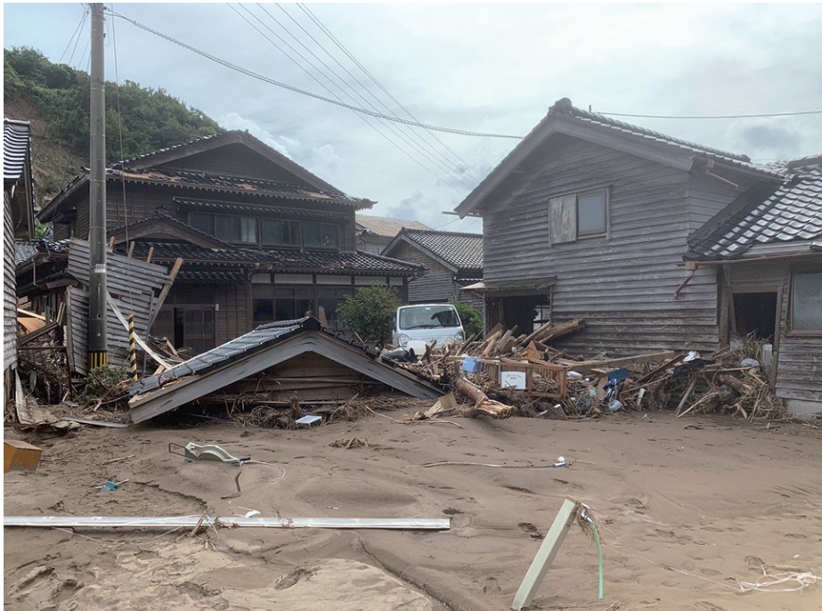
豪雨災害で流木・土砂等が侵入し、家屋が倒壊（石川県輪島市内）
