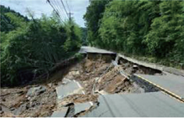
令和7年8月 大雨による道路陥没（静岡県熱海市 国道249号） 出典：国土交通省
